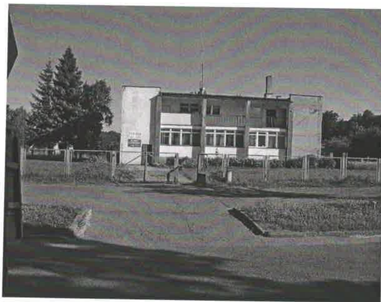
Budynek ośrodka zdrowia w Łupawie (fot. K.W.)
