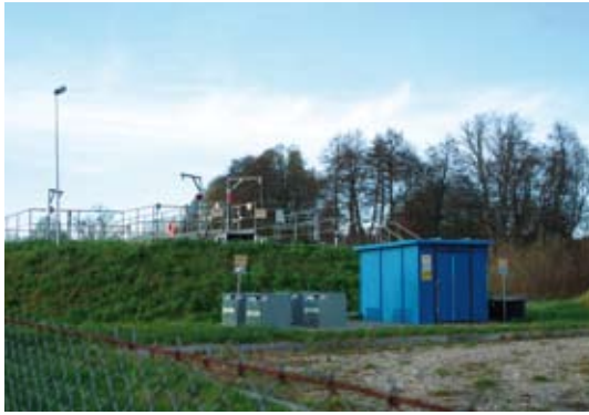
Oczyszczalnia ścieków w Łupawie
