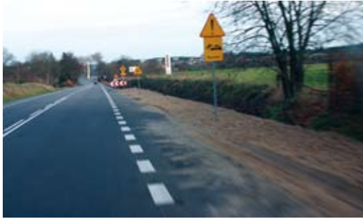
Budowa chodnika przy drodze krajowej nr 6
