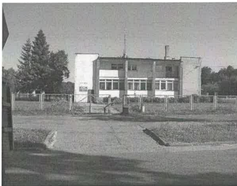
Budynek ośrodka zdrowia w Łupawie (fot. K.W.)
