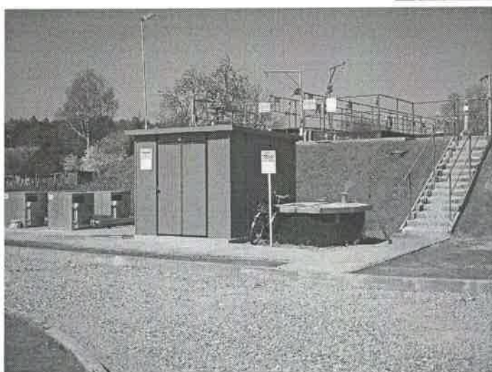
Oczyszczalnia ścieków w Łupawie (fot. K.W.)
