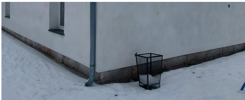
Cokół od strony południowej i zachodniej
