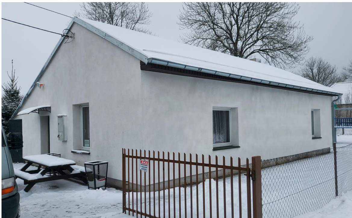
Świetlica wiejska w Dąbrównie – widok z zewnątrz, elewacja północna i zachodnia
